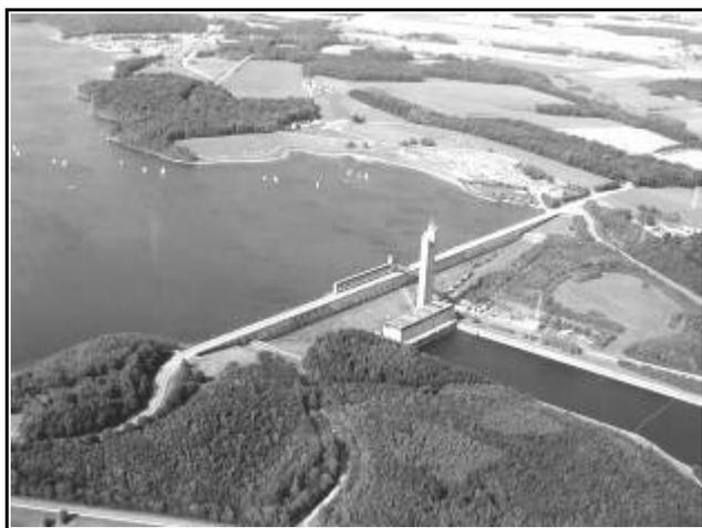
Une réserve s'avérait nécessaire pour soutenir le débit d'étiage de la Sambre, dans le souci e.a. de maintenir un débit minimum (5 m<sup>3</sup>/seconde), de réduire les effets de la pollution industrielle et urbaine, etc. Les travaux commencèrent à l'automne 1972 et se terminèrent dans le courant de l'année 1978.
